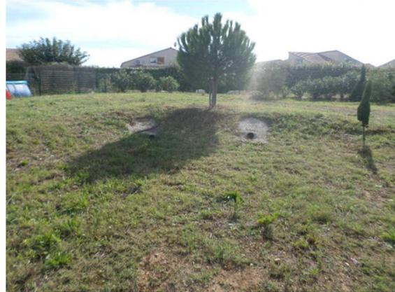
Au niveau du Chemin de la Source, la très faible capacité d'évacuation du fossé d'une part et la configuration de la voirie (présence de contre-pentes et de points bas) engendre des zones de stagnation des eaux pouvant notamment perturber la circulation et l'accès aux résidences.
