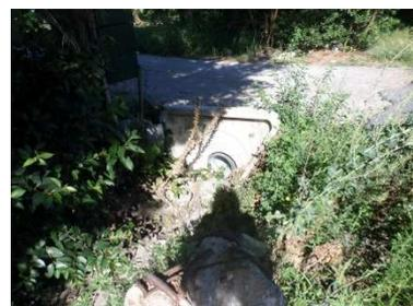
Figure 32 : Buse en Ø300 insuffisante (ouvrage 46)
