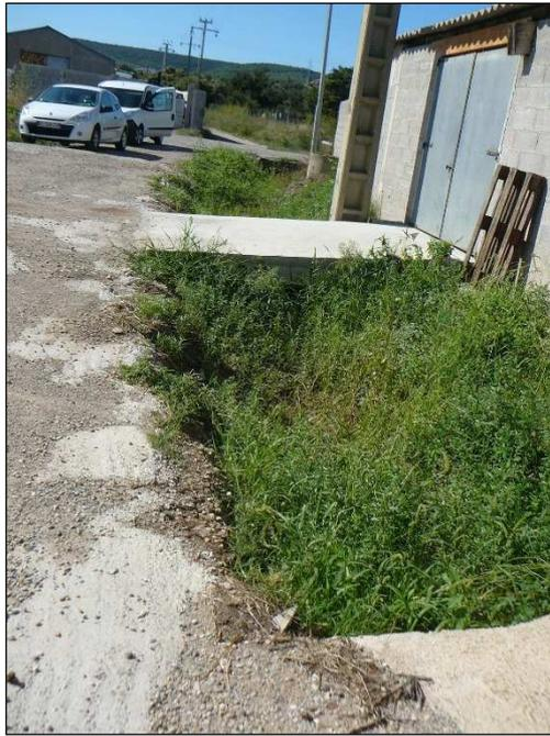
Photographie du fossé à l'amont immédiat du passage sous la voie ferrée, c'est-à-dire à l'aval de la globalité du bassin-versant urbanisé...
