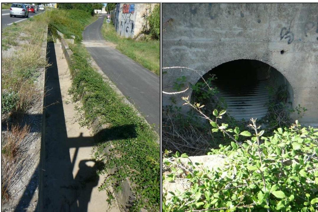
Les dimensions du passage prévu pour les eaux de la partie rurale du bassin-versant de la Canabière sous la RD612 (route de Montpellier à Sète) et du petit canal bétonné qui les conduisent ensuite vers un fossé de capacité dérisoire, telles que l'illustrent les photographies ci-dessus, apparaissent de façon évidente, bien peu cohérentes avec l'évacuation de débits de plusieurs  $\text{m}^3/\text{s}$  comme ceux précédemment estimés.
