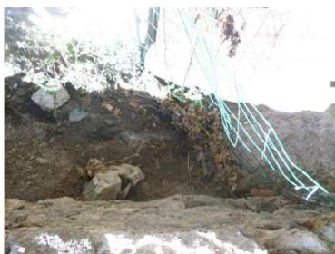
Figure 31 : Fossé de capacité insuffisante
