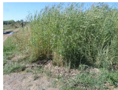
Figure 145 : Les eaux pluviales s'évacuent difficilement vers les marais
