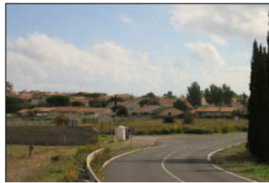
Figure 76 : Vue du site du projet depuis la RD114E3
