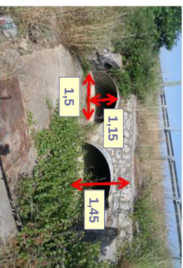
Vue de l'ouvrage (vers l'amont)
