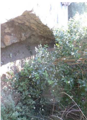
Vue de l'ouvrage (vers l'aval)
