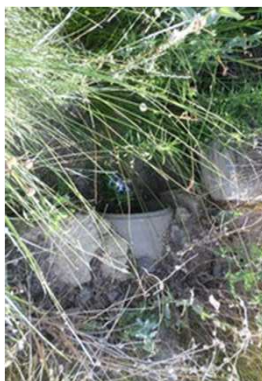
Vue de l'ouvrage 3 (depuis l'amont)
