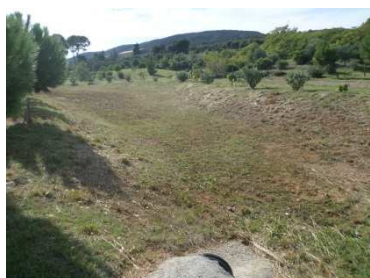
Figure 72 : Vue du bassin de rétention BR7 – depuis les buses d'entrée
