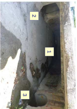
Vue de l'ouvrage (intérieur)
