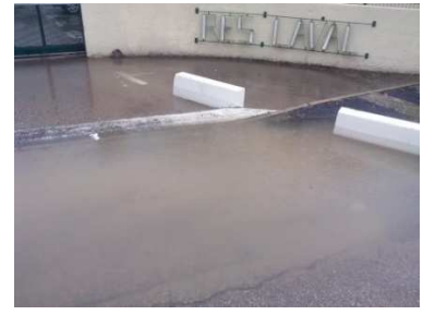
Figure 121 : Inondation de l'entrée de la résidence _ automne 2014
