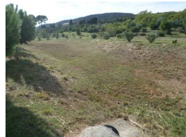
Figure 165 : Vue du bassin depuis les buses d'entrée
