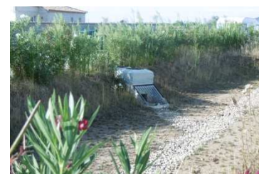
Figure 67 : Ouvrage de sortie du bassin
