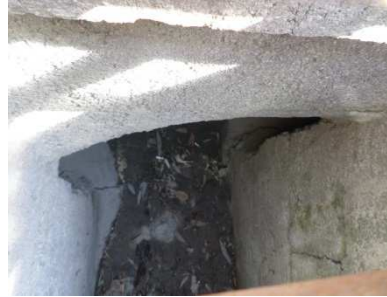
Figure 129 : Buse en Ø600 mm, à l'entrée de la résidence des Cabrols
