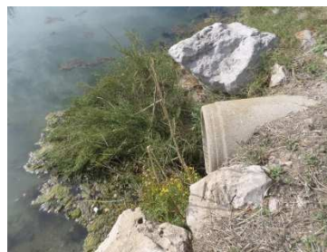
Figure 159 : Débouché de la buse en Ø600 dans la Robine (ouvrage O57)
