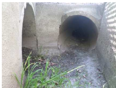
Figure 132 : Ouvrage O40 - débouché des réseaux pluviaux de la rue des Cresses et de la résidence Les Cabrols
