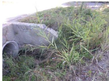
Figure 104 : Ouvrage de franchissement (O44) – les eaux pluviales sont passées par-dessus
