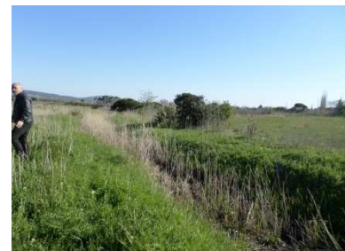
Figure 108 : Fossé enherbé – en eau - acheminant les eaux pluviales à la Robine
