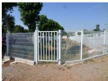
Figure 52 : Bassin de rétention BR3
