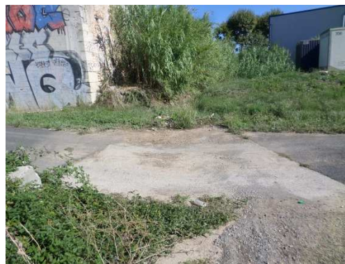
Figure 61 : La Canabière au niveau du passage sur le chemin de la Tieulière
