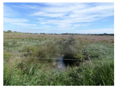
Figure 154 : Fossé non entretenu présentant une contre pente (eau stagnante)
