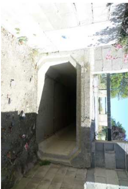
Vue de l'ouvrage (depuis l'amont)
