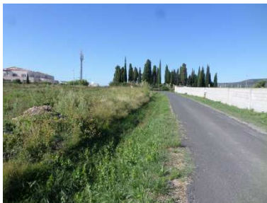
Figure 100 : Fossé enherbé le long du Chemin Bas de Saint Georges
