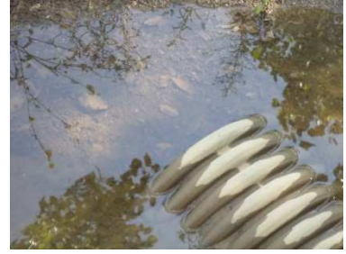
Figure 96 : Débouché de la 1 ère buse dans le fossé enherbé
