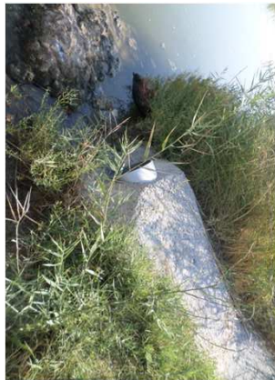
Vue de l'ouvrage (vers l'amont)
