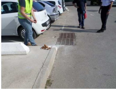
Figure 128 : Grille pluviale à l'entrée de la résidence des Cabrols
