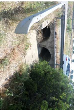
Vue de l'ouvrage (à l'amont de la route)
