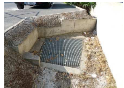
Figure 127 : Exutoire de la grille R295, de l'autre côté de la rue des Cresses (ouvrage O39)
