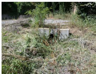
Figure 47 : Arrivée principale dans le bassin
