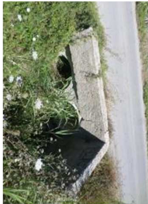
Vue amont de l'ouvrage
