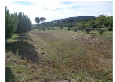
Figure 166 : Vue du bassin depuis les buses d'entrée
