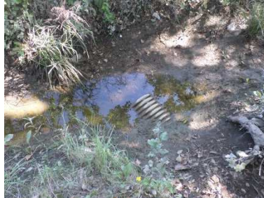
Figure 95 : Débouché de la 1 ère buse dans le fossé enherbé
