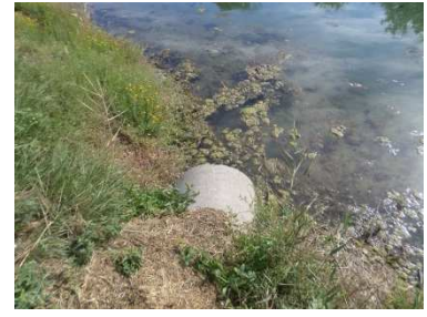
Figure 157 : Débouché de la conduite pluviale dans le Robine (ouvrage O56)
