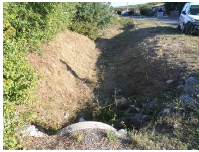
Figure 32 : Le Devès en amont du rond-point des 4 chemins
