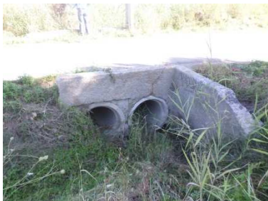
Figure 103 : Ouvrage de franchissement du Chemin Bas de Saint Georges (O44)
