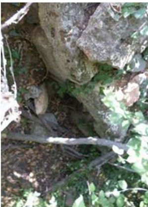
Vue de l'ouvrage (amont)
