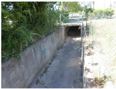
Figure 21 : La Canabière en aval de la traversée de l'avenue de Montpellier
