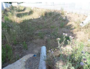
Figure 53 : Arrivée principale dans le bassin
