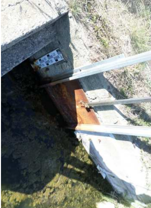
Vue aval de l'ouvrage
