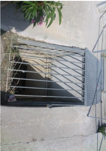
Ouvrage spécifique 1 : grille
