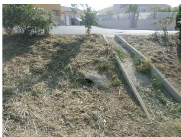
Figure 50 : Arrivée principale dans le bassin
