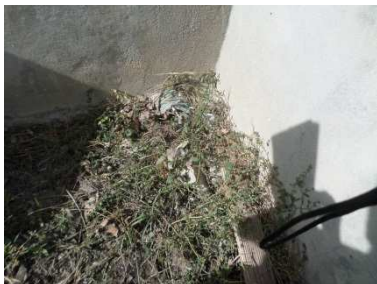
Figure 149 : Ouvrage O55 - Débouché du drain dans le fossé enherbé longeant a résidence au Sud
