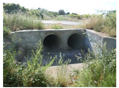
Figure 26 : Traversée du chemin de Recouly
