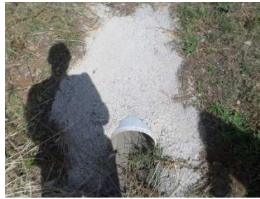
Figure 162 : Débouché dans le bassin de rétention
