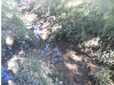
Figure 94 : Débouché de la 1 ère buse dans le fossé enherbé
