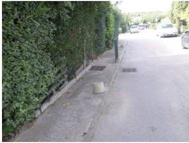
Figure 155 : Grilles pluviales pouvant se mettre en charge et déborder lors d forts événements pluvieux
