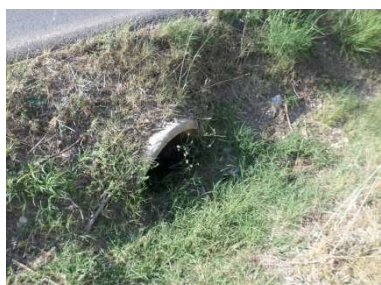
Figure 176 : Buse en Ø700 à moitié remplie de terres et herbes (O33)
