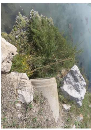
Vue de l'ouvrage
