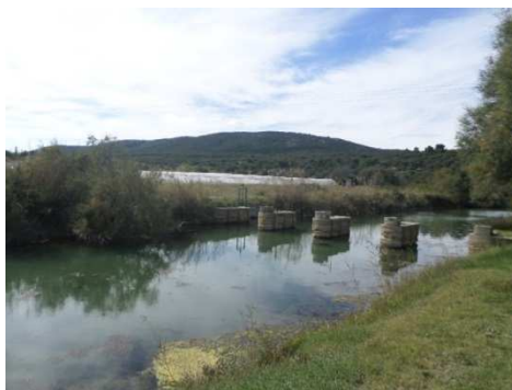
Figure 172 : Vanne martelière sur la Robine
