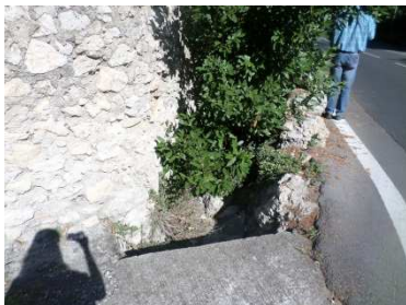
Figure 90 : Débouche du cadre (ouvrage O45)
