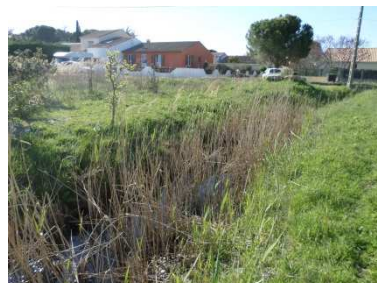
Figure 107 : Fossé enherbé – en eau - acheminant les eaux pluviales à la Robine
