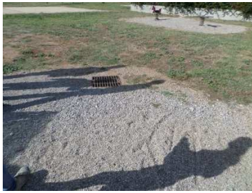
Figure 161 : Réseaux pluviaux orientant les eaux vers le bassin de rétention
