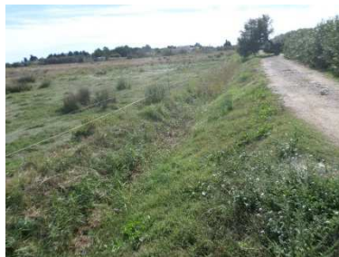
Figure 150 : Fossé longeant la résidence- correctement entretenu
