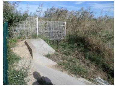
Figure 148 : Ouvrage O55 - Débouché du drain dans le fossé enherbé longeant a résidence au Sud
