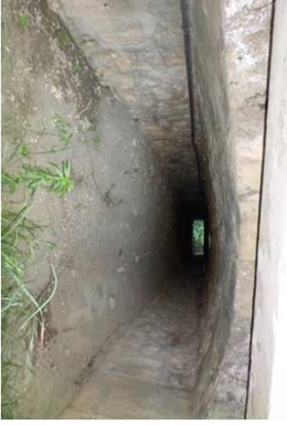
Vue de l'ouvrage (vers l'amont)
