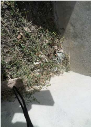
Vue de l'ouvrage
