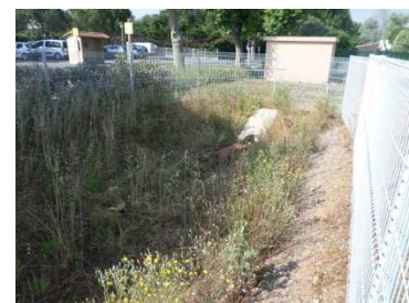
Figure 54 : Exutoire du bassin de rétention
