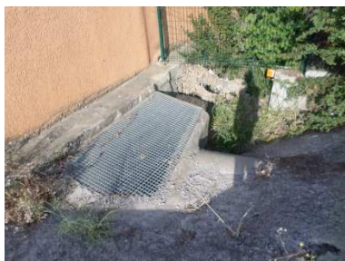
Figure 131 : Ouvrage O40 – débouché des réseaux pluviaux de la rue des Cresses et de la résidence Les Cabrols
