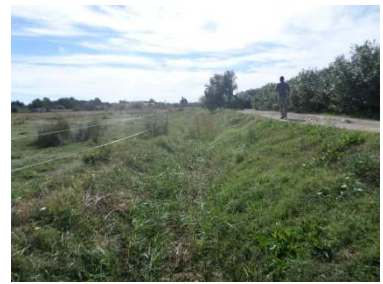
Figure 151 : Fossé longeant la résidence- correctement entretenu
