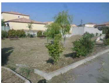
Figure 49 : Bassin de rétention BR2
