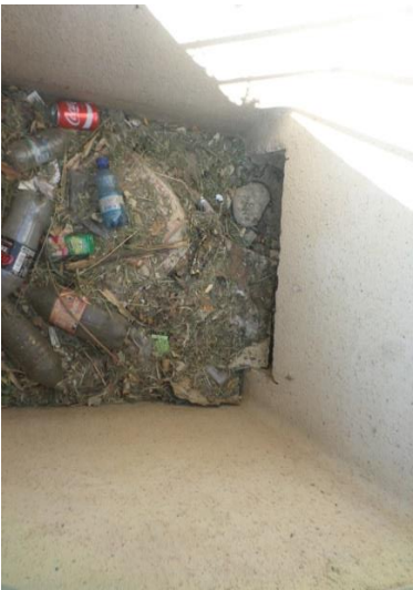
Ouvrage de sortie
