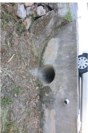
Vue de l'exutoire
