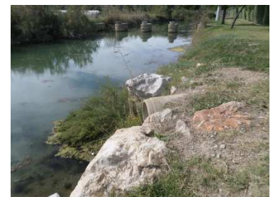
Figure 160 : Débouché de la buse en Ø600 dans la Robine (ouvrage O57)
