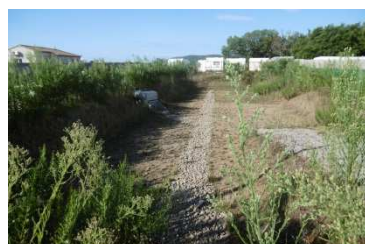
Figure 66 : Bassin de rétention BR5
