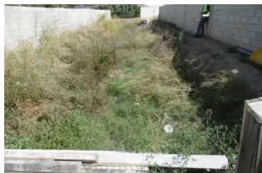
Figure 69 : Bassin de rétention BR6
