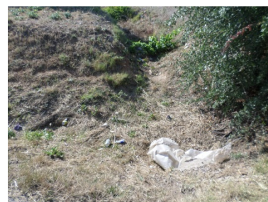
Figure 178 : Fossé enherbé au débouché de l'ouvrage O33
