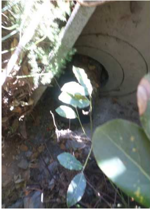
Vue de l'ouvrage (vers l'amont)
