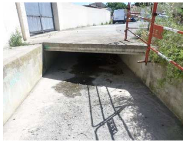
Figure 22 : Passage de la Canabière en souterrain, impasse de la Canabière
