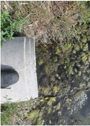
Vue de l'ouvrage
