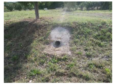
Figure 169 : Buse de sortie reliée à l'ouvrage O58
