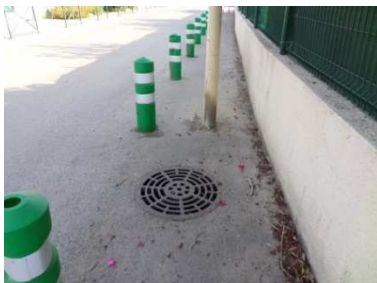
Figure 125 : Grille R295, Rue des Cresses
