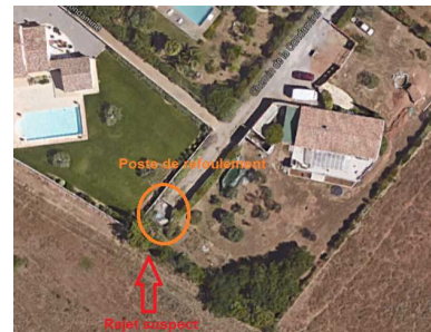
Figure 83 : Localisation du rejet suspect
