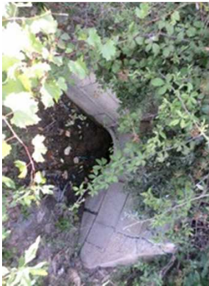
Vue de l'ouvrage (depuis l'aval)
