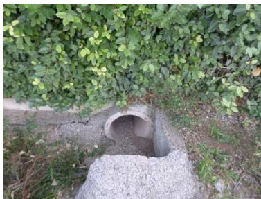
Figure 170 : Ouvrage O58 _ débouché de la buse en provenance du réseau des Jardins de la Robine
