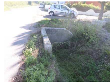
Figure 105 : Ouvrage de franchissement (O44) – les eaux pluviales sont passées par-dessus
