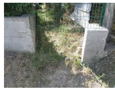
Figure 139 : Fossé enherbé longeant les habitations – débouché chemin du Marais
