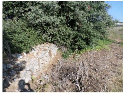
Figure 33 : Le Devès, en amont de la voie ferrée
