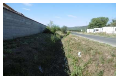
Figure 68 : Exutoire dans le fossé
