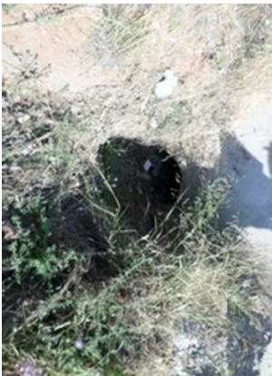
Vue de l'ouvrage (depuis l'aval)
