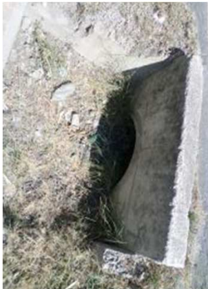
Vue aval de l'ouvrage
