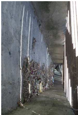
Vue de l'ouvrage (intérieur de la grille)
