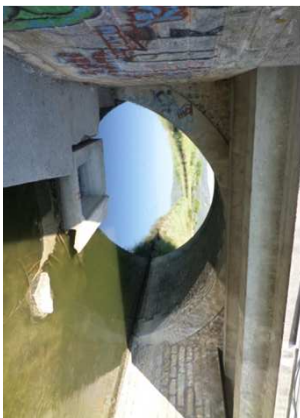
Vue de l'ouvrage (vers l'aval)
