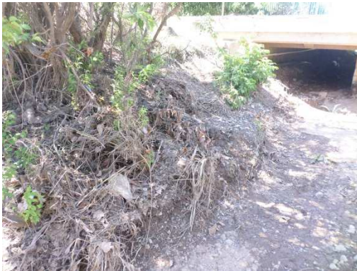
Figure 56 : La Courren au niveau de son passage sous la voie ferrée
