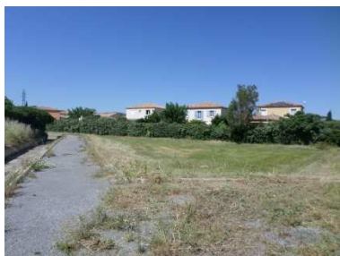
Figure 46 : Bassin de rétention BR1
